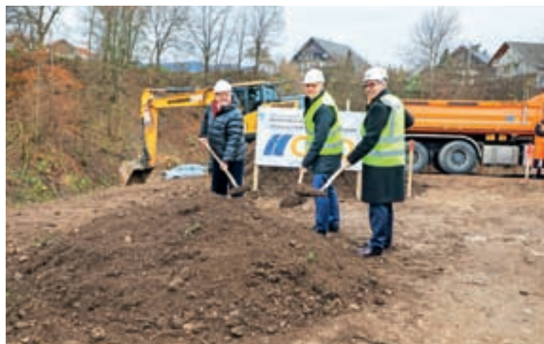
Na Betinovem klancu so konec leta 2022 zasadili prvo lopato, s tem pa naznanili začetek gradnje prve faze južne razbremenilne ceste.
