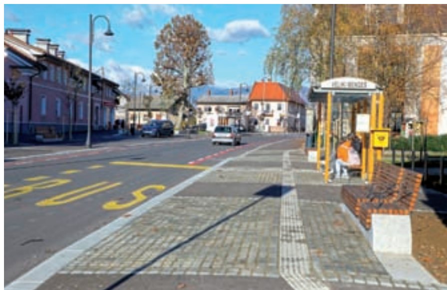
Mengeš po temeljiti prenovi Slovenske ceste / FOTO: TINA DOKL
