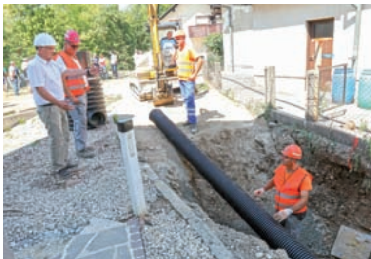
Občina Šenčur je zagotovila stoo odstotno opremljenost z javno fekalno kanalizacijo v vseh dvanajstih naseljih. Leta 2022 so na Prebačevem položili zadnjo cev kanalizacijskega sistema. / FOTO: TINA DOKL
