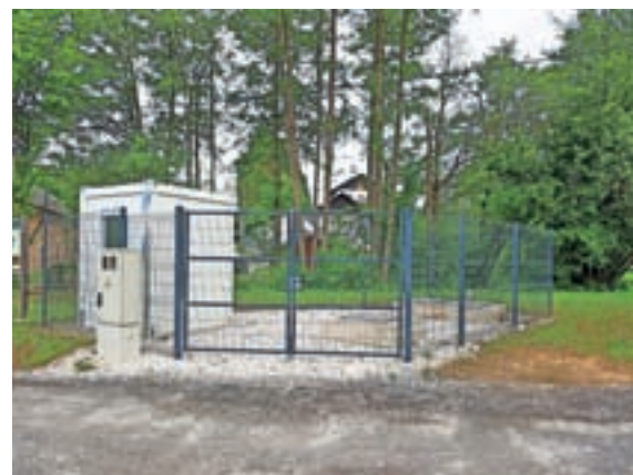
Za fekalno kanalizacijo C0 od Vodice do Ljubljane je že pridobljeno uporabno dovoljenje.
