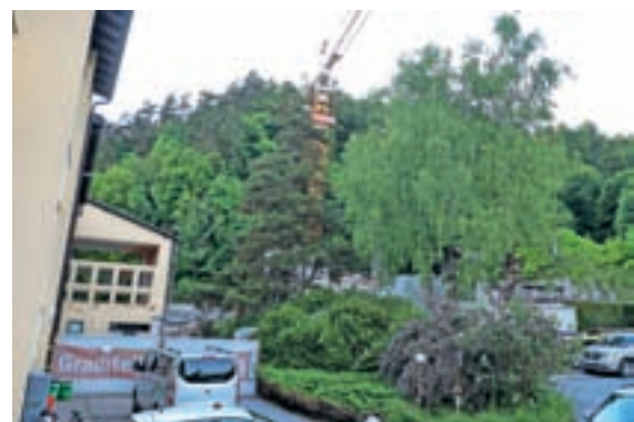
Z rekonstrukcijo in prizidavo Osnovne šole Mengeš bodo rešili prostorsko stisko. / FOTO: TINA
